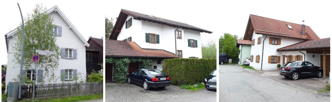
Abb. 15 Sonnenstraße 3, 6 und 11 © Planungsverband Äußerer Wirtschaftsraum München (PV)
