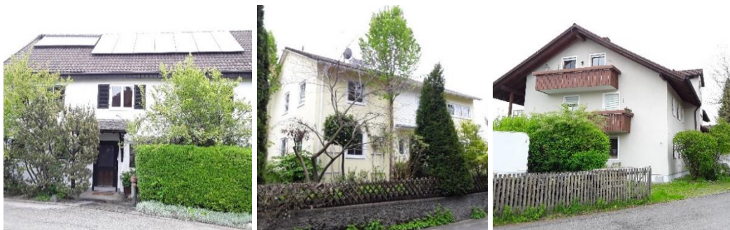
Abb. 18 Tiefenbachstraße 9, 13 und 15 © Planungsverband Äußerer Wirtschaftsraum München (PV)
