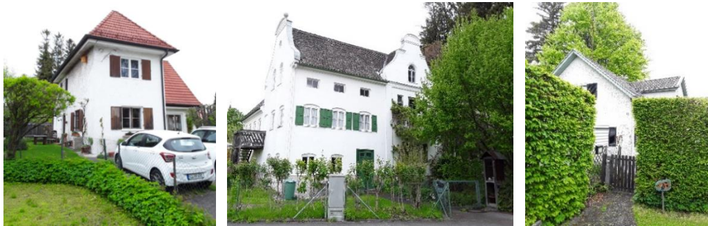
Abb. 17 Tiefenbachstraße 6, 8 und 12 © Planungsverband Äußerer Wirtschaftsraum München (PV)
