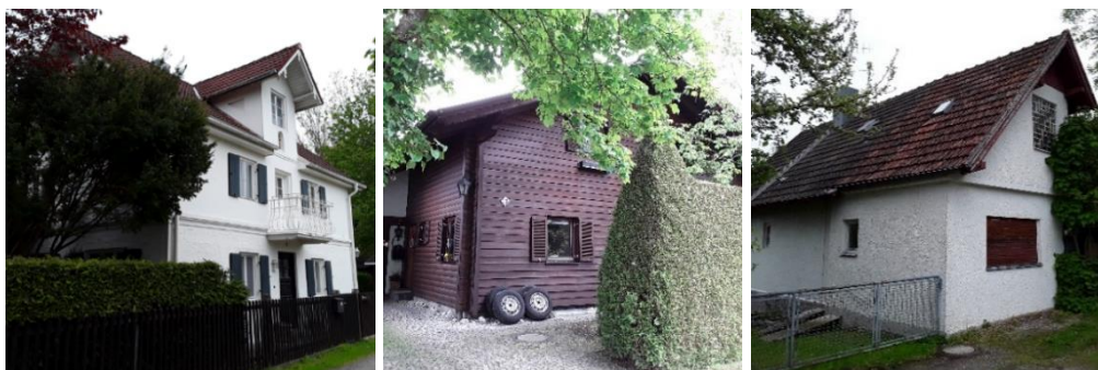
Abb. 12 Eduard-Gabelsberger-Straße 1,5 und 7 © Planungsverband Äußerer Wirtschaftsraum München (PV)
