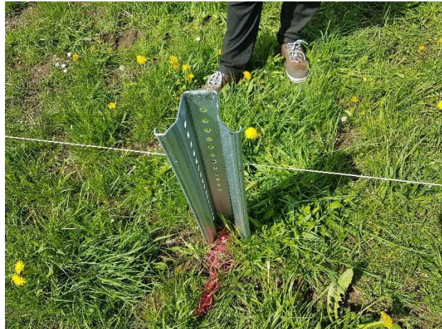
Abbildung 5: Rammfundament
